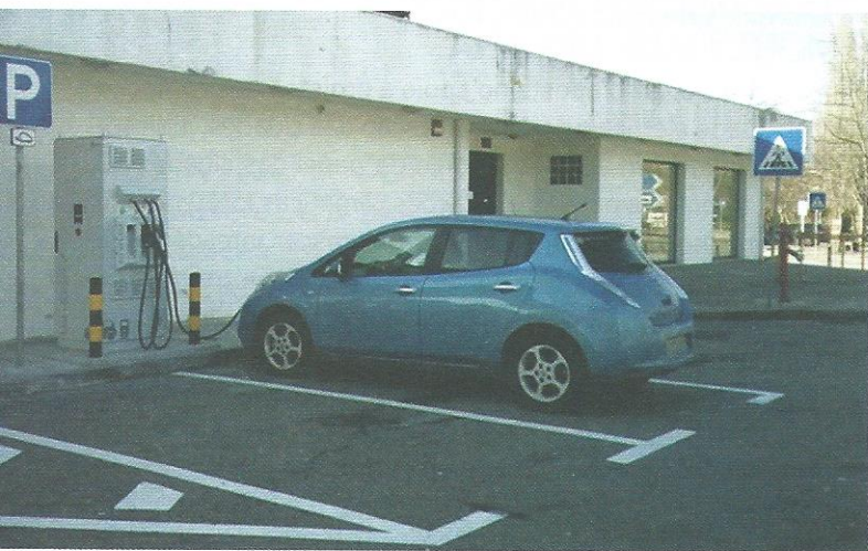
A1, área de serviço de Antuã, sul/norte
