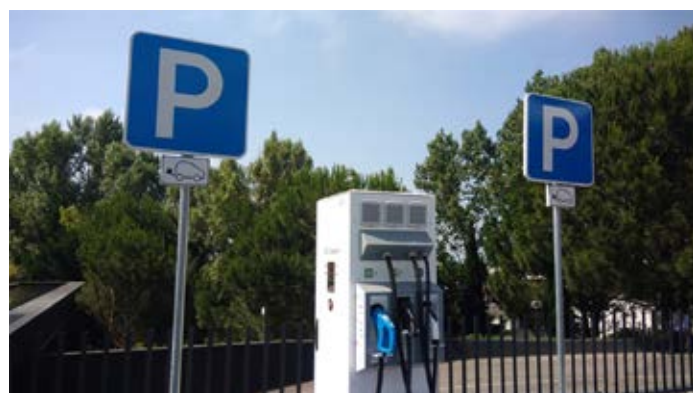
PCR com DC (CHAdeMO e CCS ambas a 50 kW) e AC (tipo 2, Mennekes a 43 kW).
