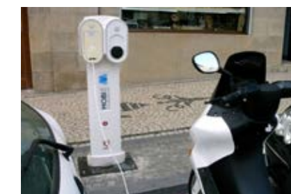
PCN tipo 1 (tomada azul/CEE) e tipo 2 a 3.7 kW.
