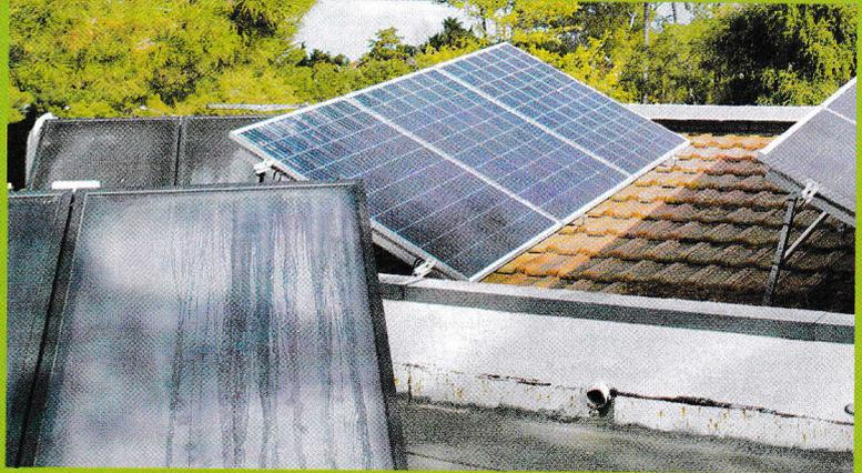
Na cobertura da habitação coabitam coletores solares e painéis fotovoltaicos, para a produção de águas quentes sanitárias e de eletricidade, respetivamente
